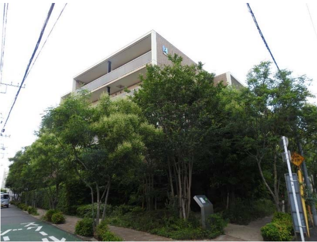
ヒューリックコート雪が谷の外観
