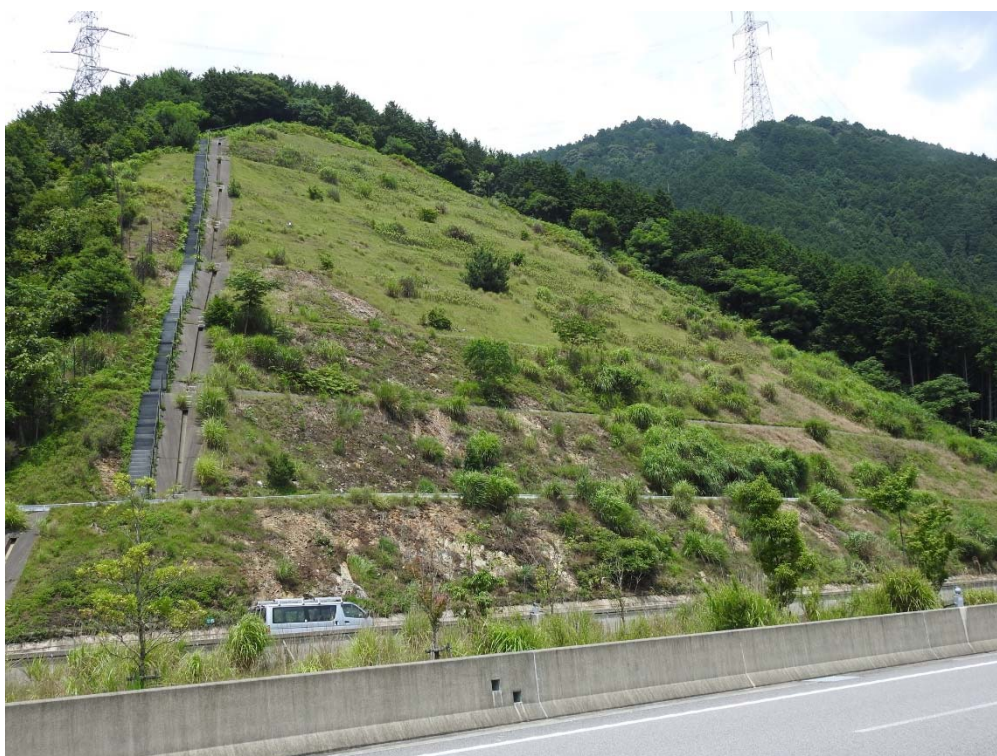
図. 植生が回復しつつある切土法面
