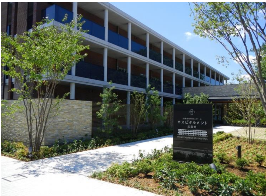
図. 竣工直前の外構（2013 年撮影）
