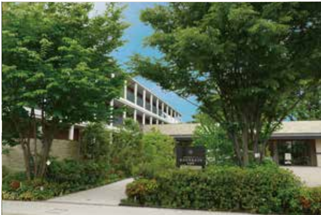
メインエントランスからの外観
