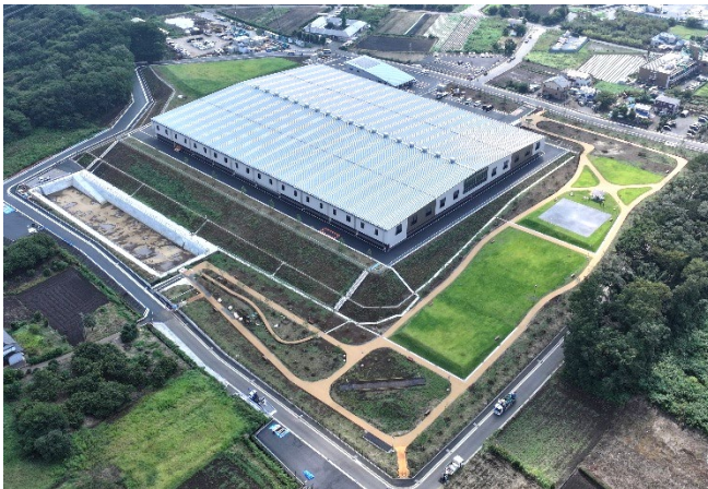
上空からの敷地全景
