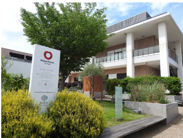
エントランス周辺の植栽
