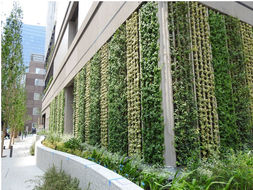
図. 外構植栽と壁面緑化
