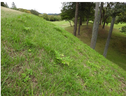
ティー脇法面
