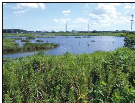
芝川第一調節池 (埼玉県さいたま市・川口市)
