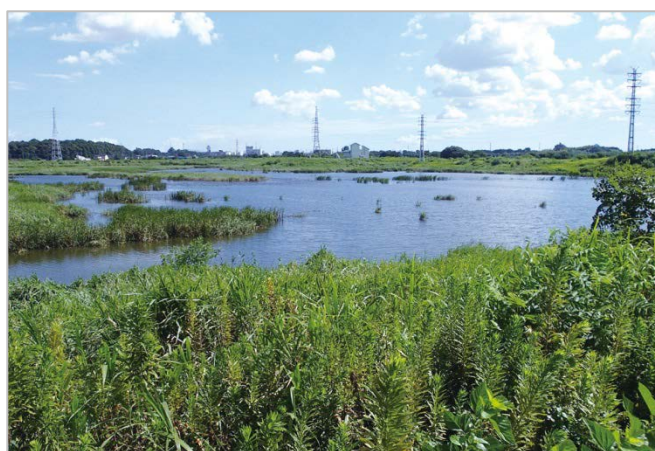
芝川第一調節池（事業地：埼玉県さいたま市・川口市）
