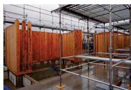
図2 一般の柱材を組み合わせた縦ログ
