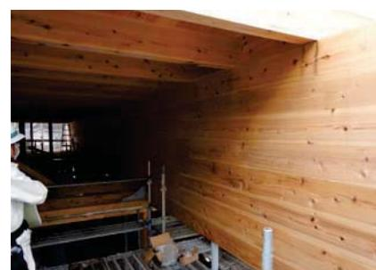
図3 積雪対策のため8本の梁を合わせた重ね梁
