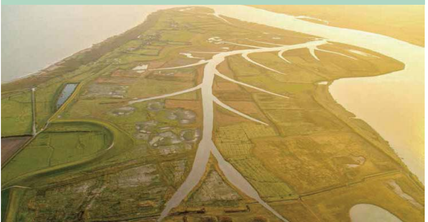
堤防の一部を撤去して潮の干満を利用した湿地を再生。満潮時には広大な水面が現われます
