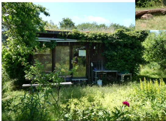
地面だけでなく、屋根の上も野草が繁茂
