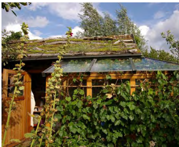
地域の草花に囲まれたエコラウベの休憩小屋
