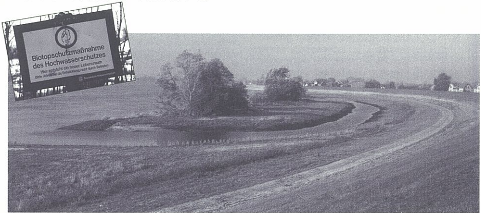
堤防の付け替えが行われた場所。「洪水高潮防御に際してのピオトープ保護措置—生物生息空間が新たにここに生まれる—」と書かれた啓発用の看板が立てられています。
