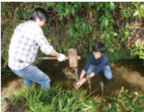
湧水を集めて流れるママ下水路の護岸を補修しています
