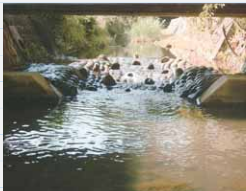
落差工を改良して、当時、世界で3か所しか設置されていなかった先進的な魚道が整備されました
