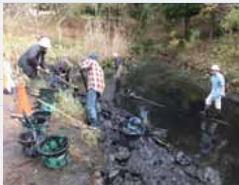
トンボ池の本格的なかいぼりは初めてのことで、ヘドロ状の黒い泥は 10 年間に堆積した腐植質です
