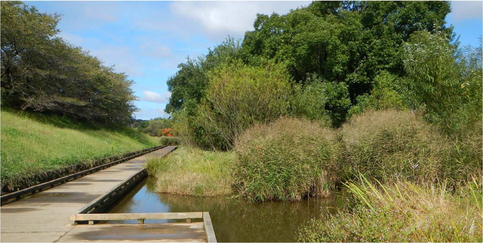
金山調節池(東京都清瀬市)
