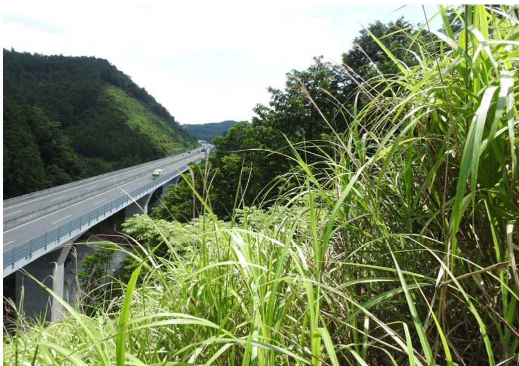
図. 紺東・柿本地区の全景
