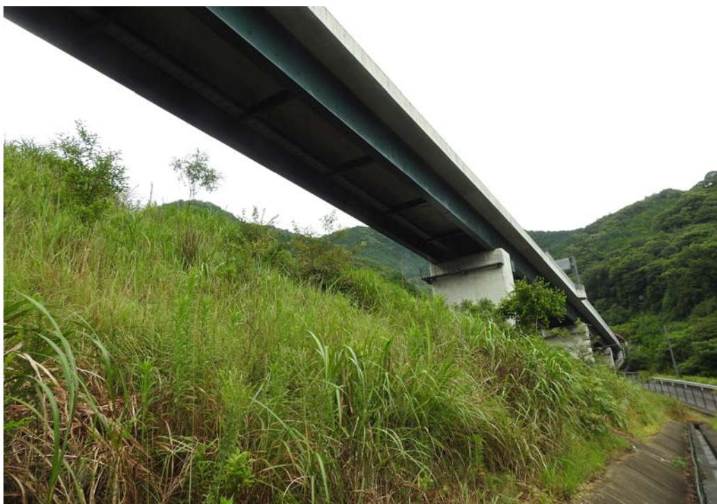
図. 地域性苗木が植栽された区画
