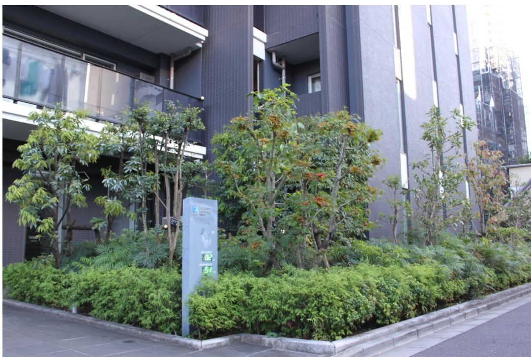
図. 第2回更新時のヒューリックレジデンス新宿戸山の外構（2023年撮影）
