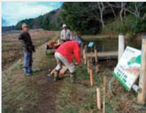
ヘイケボタルやニホンアカガエルがすむ湿地を保全するために設置した立ち入り防止柵の補修作業
