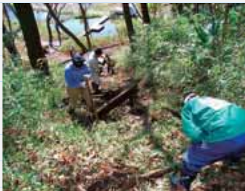
観察路に設置した階段の補修作業
